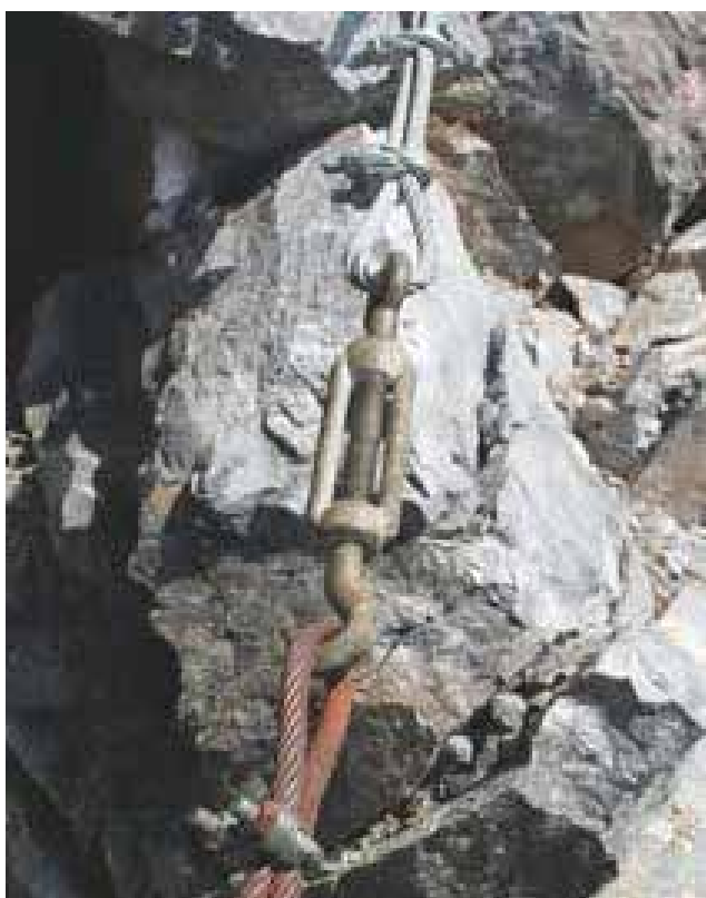
Slika 51: Odprt napenjalni sistem v varovalni verigi.
