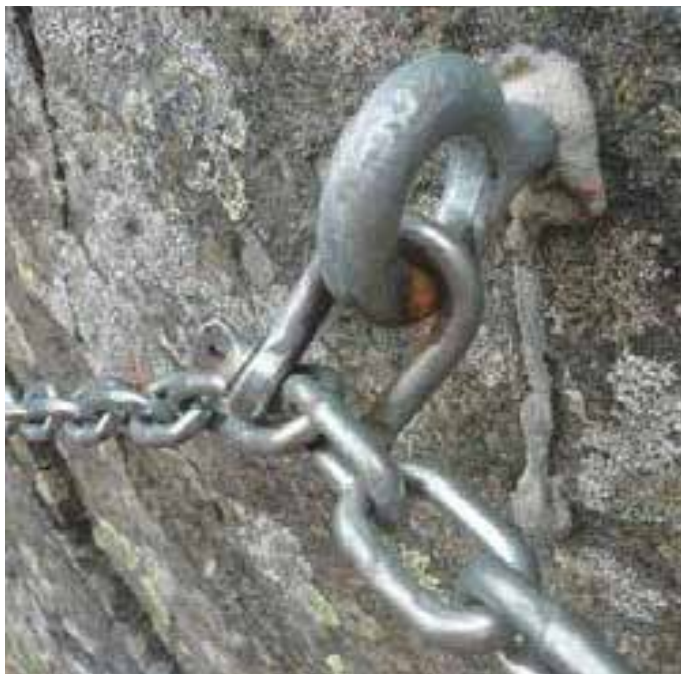
Slika 54: Vsaka veriga je tako močna, kot je močan njen najšibkejši člen; ta način varovanja (namesto jeklene vrvi) ni optimalen (še sprejemljiv), vendar naj ne bo v nobenem primeru uporabljen v zavarovanih plezalnih poteh! Vijačni sistem naj bo vedno fiksiran!
