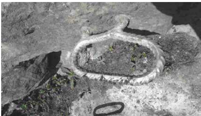
Slika 26: Stopno krožno pomagalo iz obstojnega jekla (vroče cinkano) ne vsebuje strih robov. V primeru stopanja na rob ne pride do zasuka pomagal.
