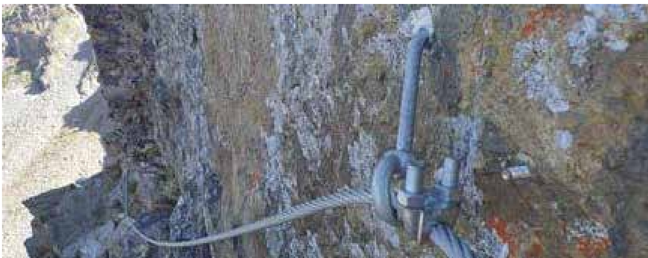
Slika 37: Glej komentar pod sliko 36. Dolžina in debelina sidra kot način pritrjevanja so neustrezni.
