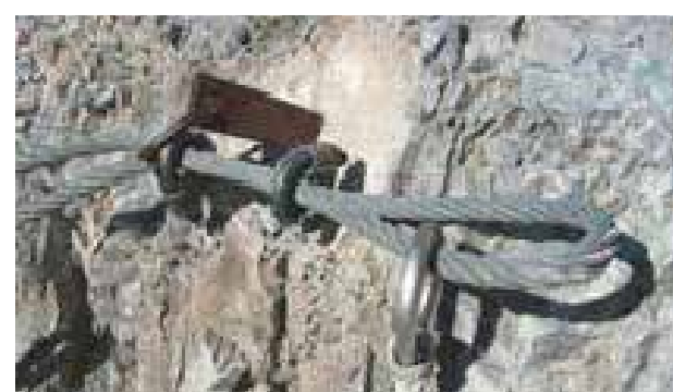
Slika 46: Nedopustna oblika podaljševanja vrvi.
