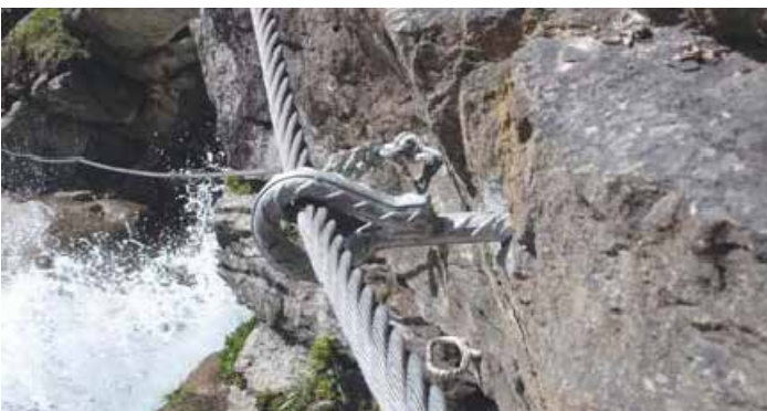
Slika 30: Vmesno očesno sidro iz prednapetega jekla z močno prednapeto jekleno vrvjo (notranja stran očesa je gladka in brez robov)
