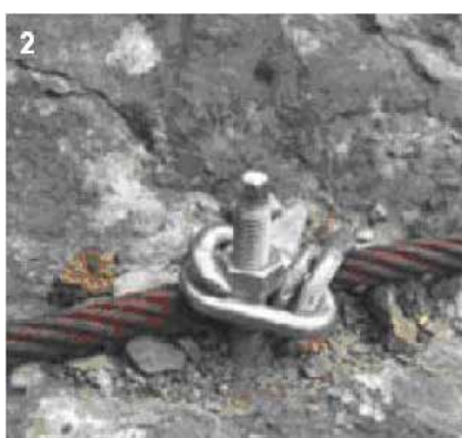
Slika 39: 1, 2, 3 – o zadostni nosilnosti sidra tukaj ne moremo govoriti!
