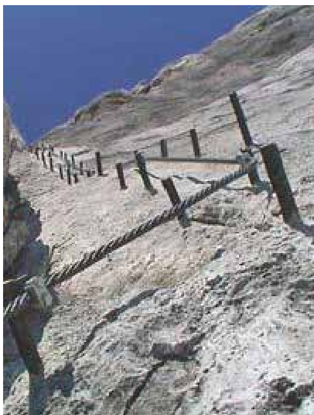
Slika 52: Stopni klini predstavljajo povečano nevarnost poškodb.
