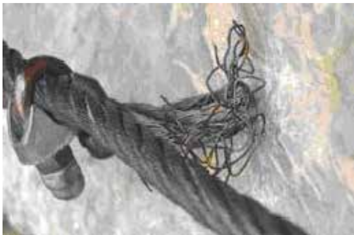
Slika 28: Poškodovana jeklena vrv
