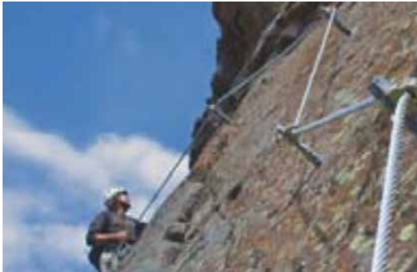
Slika 35: Dobro stanje sider, poravnana – blago napeta jeklena vrv, dober izbor smeri poti, uporaba naravnih stop in oprimkov.
