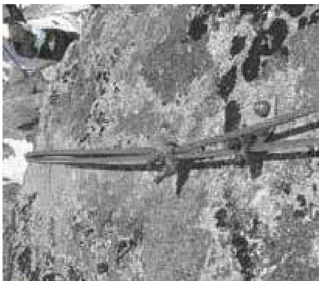
Slika 40: Potek jeklene vrvi direktno skozi svedrovec: nevarnost poškodb jeklene vrvi, premajhna oddaljenost jeklene vrvi od skale.
