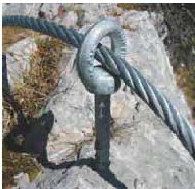
Slika 49: Obročne matice nimajo prečne nosilnosti.
