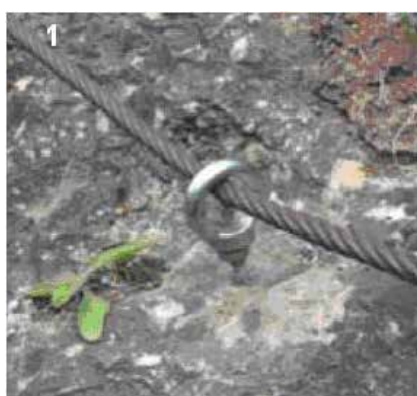
Slika 39: 1, 2, 3 – o zadostni nosilnosti sidra tukaj ne moremo govoriti!
