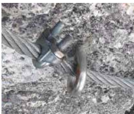
Slika 38: Spojka jeklene vrvi pred in po očesu vmesnega sidra ni priporočljiva.
