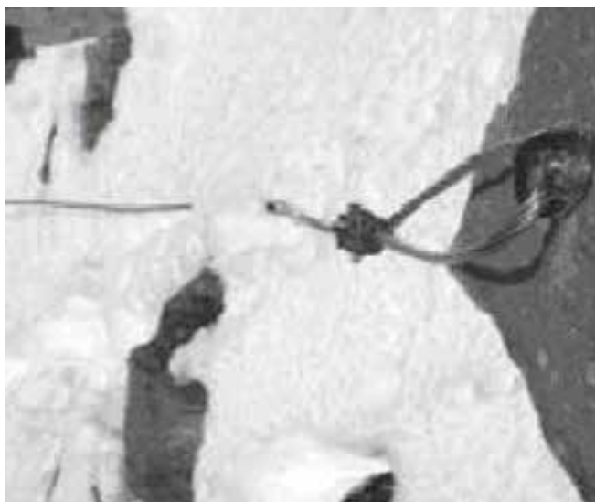
Slika 40: Potek jeklene vrvi direktno skozi svedrovec: nevarnost poškodb jeklene vrvi, premajhna oddaljenost jeklene vrvi od skale.
