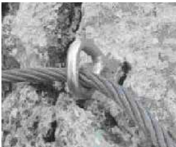
Slika 42: Pretanka jeklena vrv; premalo spojk za jekleno vrv, zanka jeklene vrvi brez notranjega vložka; standardni svedrovci so sicer dovoljeni, vendar bi bilo pravo sidro veliko primernejše.
