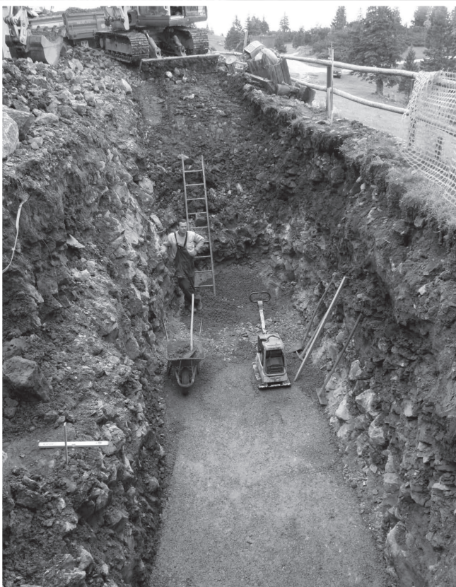
Izkop za biološko čistilno napravo zmogljivosti 12 do 16 populacijskih enot.
