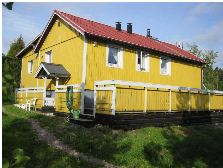
Prikupno domovanje v naselju Navekvaren
